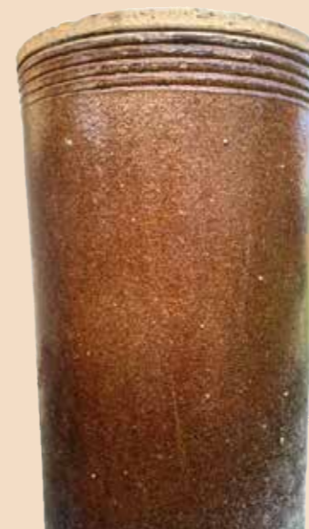
Obr. 79 Část kameninového odpadního potrubí Bild 79 Ein Teil einer Steinzeug-Abwasserrohrleitung
