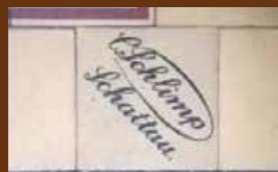
Obr. 107 Označení lícni strany interiérové dlažby slovy: C. Schlimp Schattau. (Šatov) Bild 107 Markierung der Vorderseite der Platte für Innenbereiche mit Worten: C. Schlimp Schattau. (Šatov)
