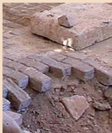
Obr. 27 Pokládka stájových dlaždic z šatovské továrny ve stájích královského paláce v maďarském Gödöllő Bild 27 Verlegung der Stall-Pflastersteine aus der Tonwarenfabrik in Šatov in den Ställen des Königspalastes im ungarischen Gödöllő
