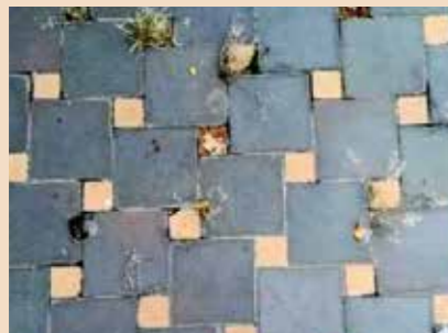
Obr. 22 Silniční dlažba v Šatově na příjezdové cestě k nádraží a ke keramické továrně Bild 22 Straßenpflasterung in Šatov auf dem Zufahrtsweg zum Bahnhof und zu der Tonwarenfabrik
