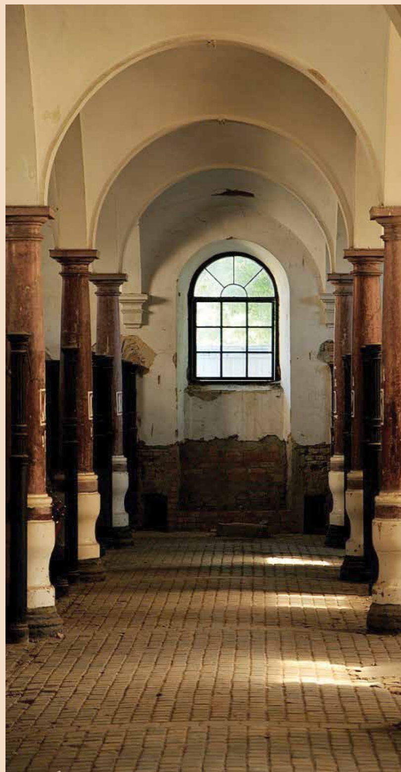
Obr. 28 Pokládka stájových dlaždic z šatovské továrny ve stájích královského paláce v maďarském Gödöllő Bild 28 Verlegung der Stall-Pflastersteine aus der Tonwarenfabrik in Šatov in den Ställen des Königspalastes im ungarischen Gödöllő
