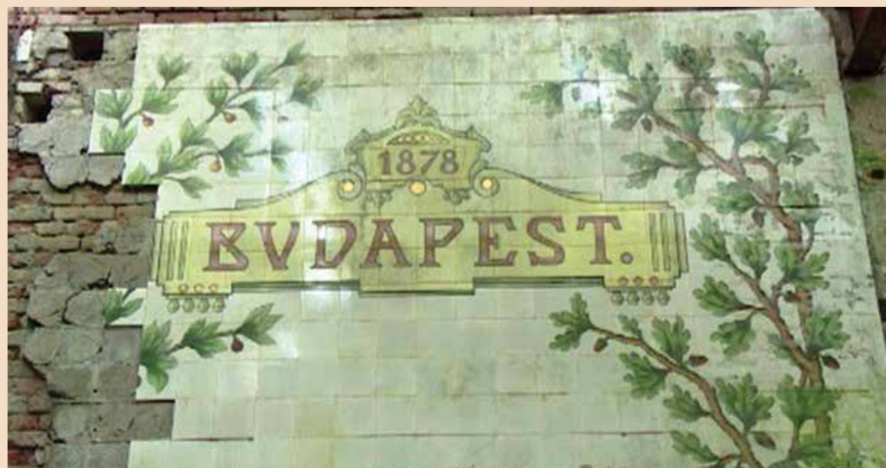
Obr. 71, 72 Bílé šatovské obkladové dlaždice doplněné o velkoprostorovou malbu, umístění v Ottově pavilonu lázní Kyselka Bild 71, 72 Weiße Verkleidungsplatten, ergänzt um eine Großformatmalerei, platziert im Quellentempel im Kurort Kyselka
