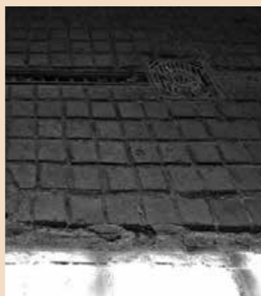
Obr. 26 Pokládka stájových dlaždic z šatovské továrny ve stájích královského paláce v maďarském Gödöllő Bild 26 Verlegung der Stall-Pflastersteine aus der Tonwarenfabrik in Šatov in den Ställen des Königspalastes im ungarischen Gödöllő
