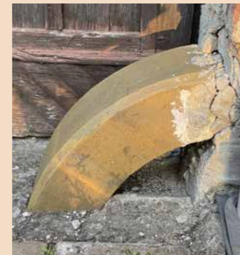
Obr. 78 Fotografie Ochranného oblouku Bild 78 Fotografie eines Schutzbogens
