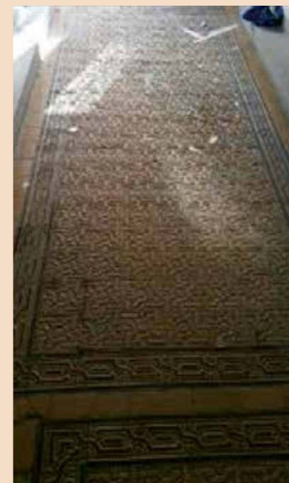
Obr. 30 Pokládka jemných dlaždic ve vídeňském domě (vzory VII, XXI, XX) Bild 30 Verlegung feiner Platten in einem Haus in Wien (Muster VII, XXI, XX)
