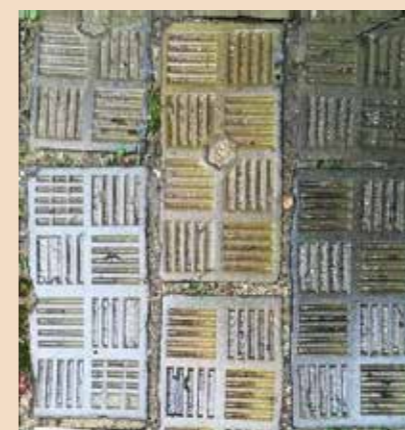
Obr. 93 Slinuté cihly s vlisovanými drážkami použité pro dláždění Bild 93 Gesinterte Ziegel mit eingepressten Rillen, benutzt für Pflasterung
